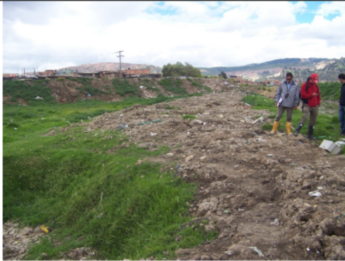
Fotografía 21. Lodos dispuestos en el margen derecho de la Quebrada Tibanica, predio la María.
