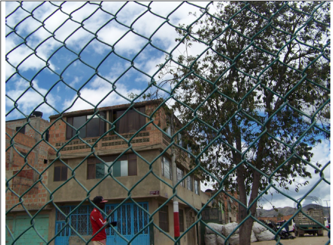
Fotografía 2. Sector de instalación del pontón metálico provisional. Calle 40 B con carrera 24, Municipio de Soacha.
